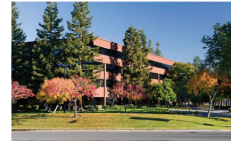
ZUKEN SOZO Center (USA)
