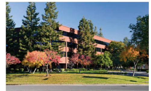
ZUKEN SOZO Center (USA)
